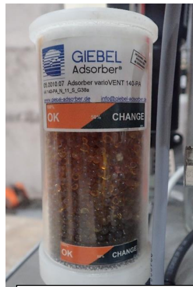
3. Beladung findet nur noch von unten statt. Anlageninnenraum ist trocknet und keine neue Feuchtigkeit strömt hinein!
